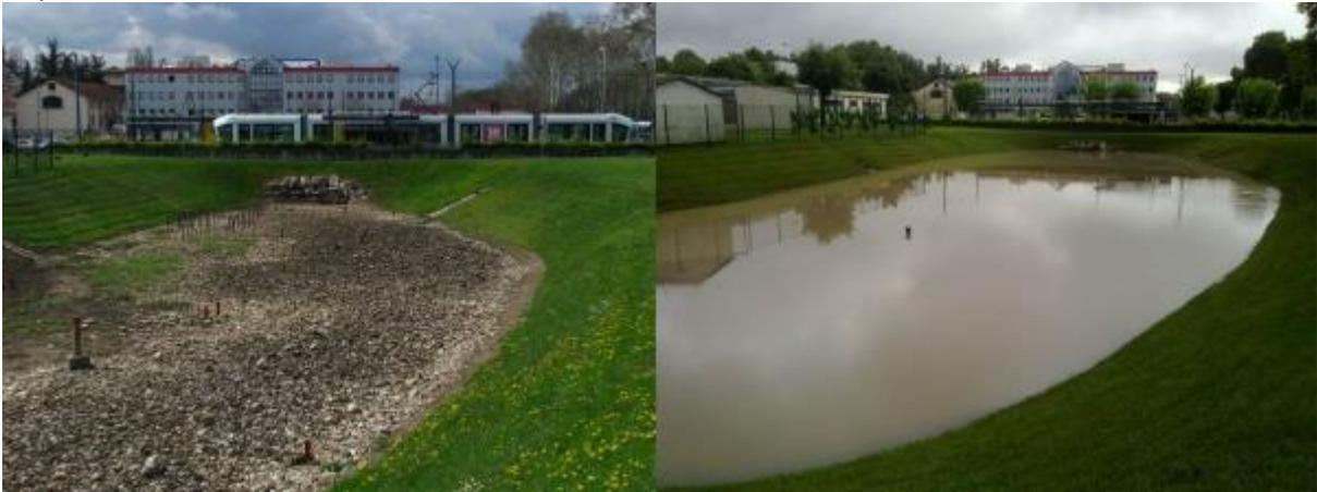
Figure 2 : Le bassin d'infiltration des eaux pluviales de l'IUT, campus de La Doua (source : GRAIE)
