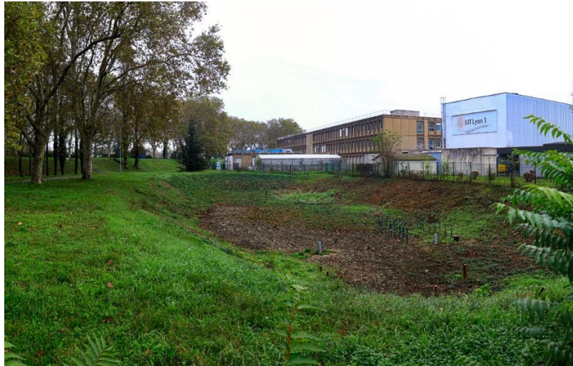
Figure 2 : Système de récupération des eaux de pluies de première génération, Campus de la Doua, Arnaud Foret, 2024
