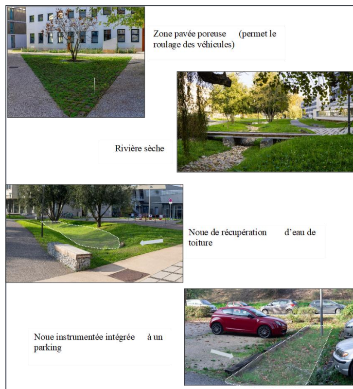
Figure 4 : Entre recherche scientifique et gestion des eaux pluviales du campus de la Doua, des dispositifs techniques à la source de l'OTHU, les flèches bleues représentent l'arrivée de l'eau, Arnaud Foret, 2024.
