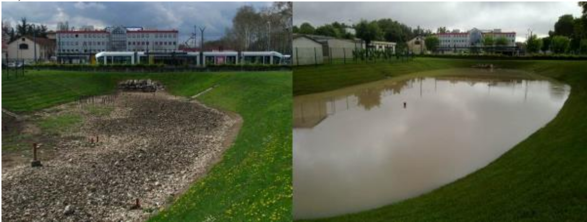
Figure 2 : Le bassin d'infiltration des eaux pluviales de l'IUT, campus de La Doua (source : GRAIE)
