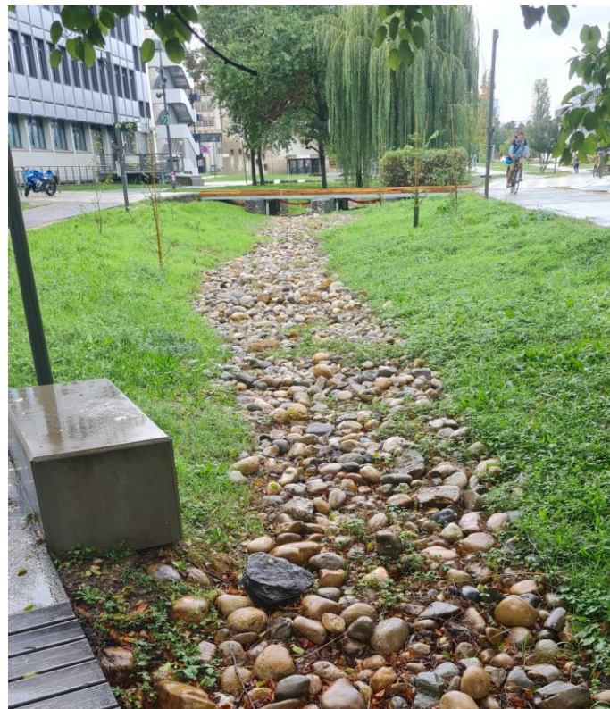
Rivière sèche, ouvrage d'infiltration sur le campus de la Doua (©Master2 IWS)
